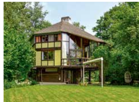
Lisbeth Sachs: Ferienhaus «Im Schilf» am Hallwilersee, Aesch LU, 1964–1967
